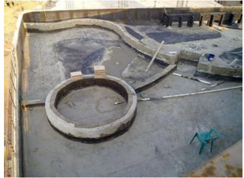
شكل (١٢) اعمال المباني
