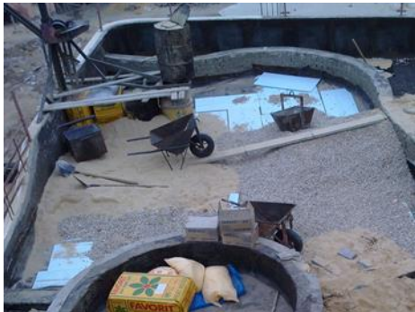
شكل (١٥) عازل حرارة للتزيبه سمك اقل من ٢٠ سم
