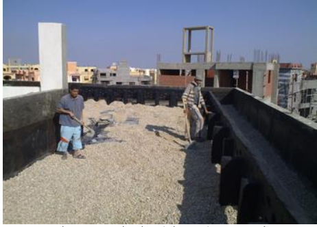
شكل (١٣) طبقة زلط فولى لتصريف المياه
