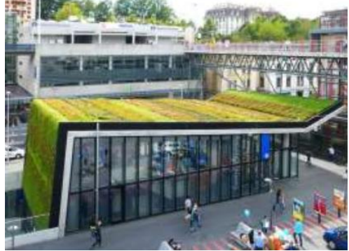
شكل (٦) يوضح محطة مترو في لوزان، سويسرا
